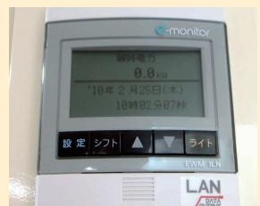
分電盤ごとの消費電力量を測定し、そのデータを職員室のパソコンで集計できるシステムを導入しました。
