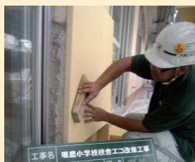
断熱材には石油を使っていない、カルシウムを主原料としたLICボードを採用しました。
